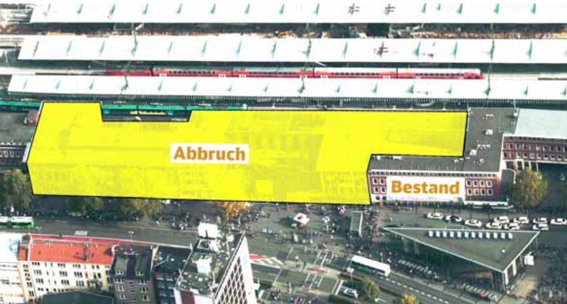
Luftbild des Münsteraner Hauptbahnhofs mit den Gebäudeteilen, die zurückgebaut werden bzw. erhalten bleiben. Foto: DB Station&Service AG
